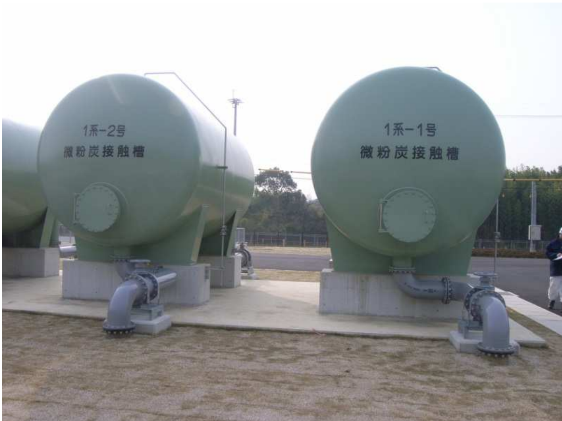
粉末活性炭（微粉炭）接触槽
